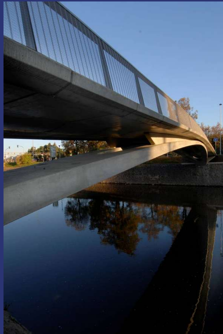
Lávka přes Svatku, Brno, ČR
